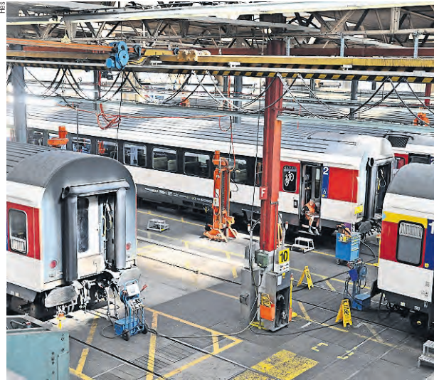
Les Ateliers CFF de Zurich-Altstetten.
