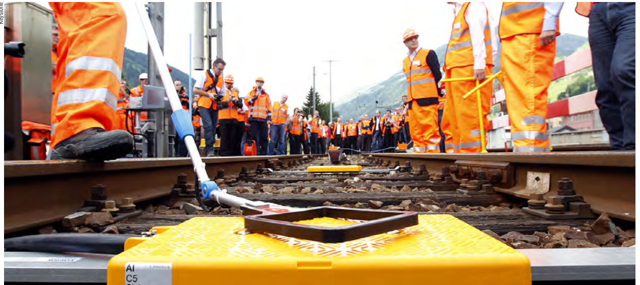
L'avenir est aux balises (photo de la mise en place de la première balise ETCS en été 2012 à Airolo).
