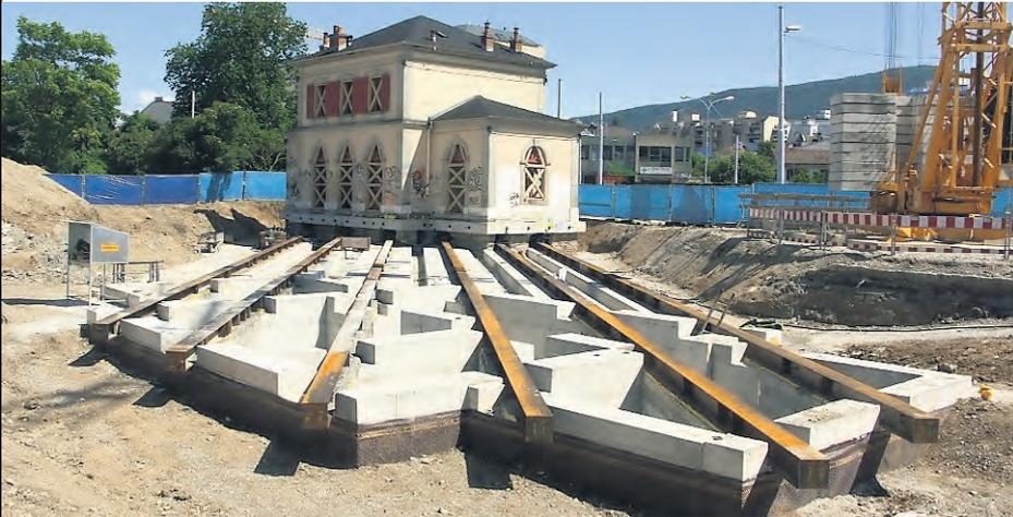
Die Arbeiten für die Genfer Verbindungsbahn Cornavin–Eaux-Vives–Annemasse (Ceva) sind in vollem Gang. Dazu gehört auch die Verschiebung des denkmalgeschützten ehemaligen Aufnahmegebäudes von Chêne-Bourg aus dem Jahre 1888 um 40 Meter nach Norden. Das Bild vom 30. Juni zeigt das auf sechs Stahlschienen gesetzte Gebäude. Die Verschiebung hat inzwischen stattgefunden. Sie ermöglicht den Bau der neuen Doppelspur in Tiefelage.
