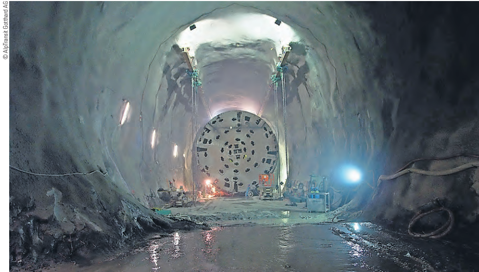
Der SEV lehnt den Bau einer zweiten Autobahn-Tunnelröhre am Gotthard ab. Der Eisenbahn-Basistunnel, hier im Bild während des Baus unter Sedrun, würde zu einer nachhaltigeren Lösung beitragen.
