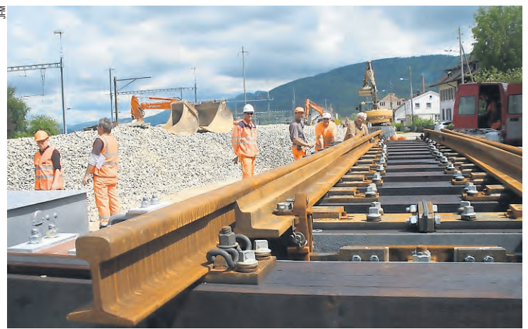
A la gare de Glovelier, la ligne CJ sera mieux intégrée au réseau national des CFF.
