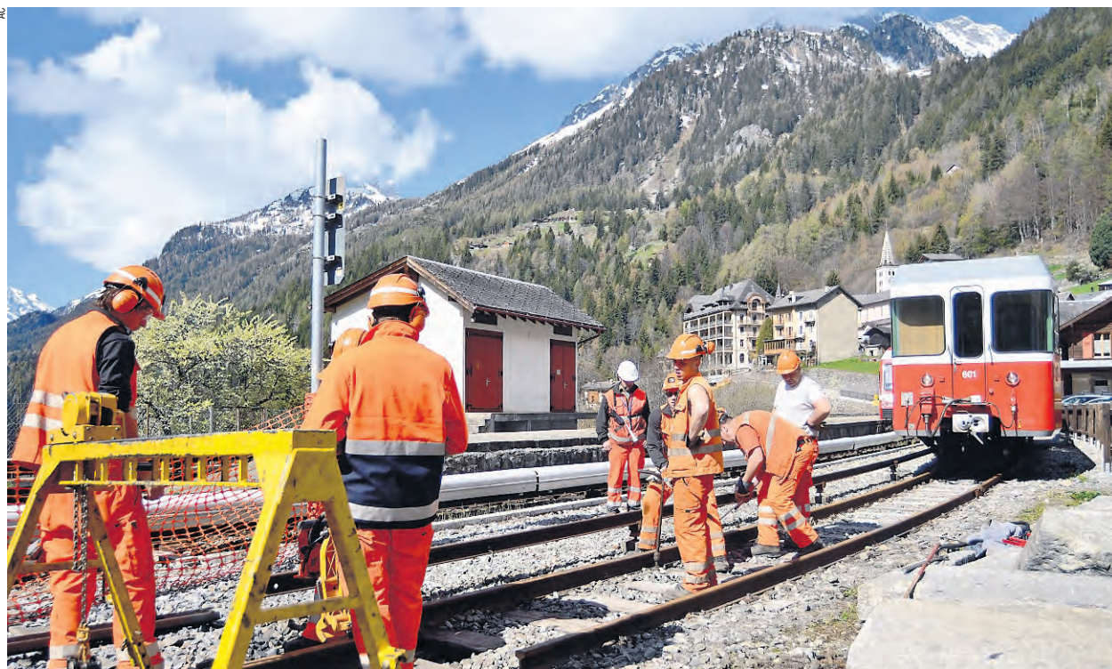
Les apprentis monteurs en voies ferrées à Finhaut, sur la ligne du Mont-Blanc Express.
