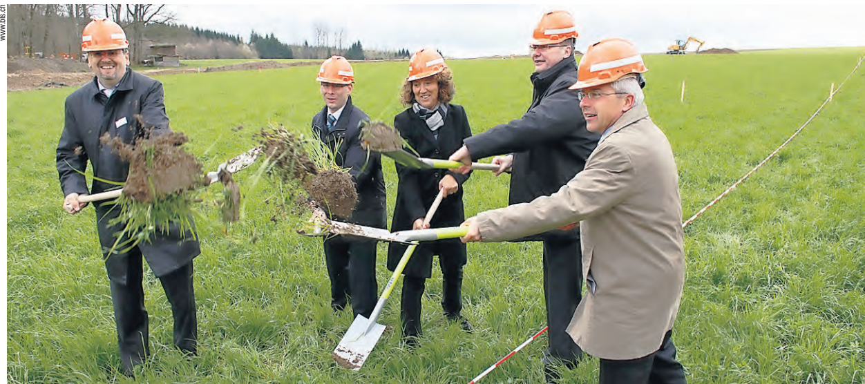
CEO und Verkehrsbesteller (v.l.n.r.): BAV-Direktor Peter Füglistaler, BLS-CEO Bernard Guillemon, die Berner Regierungsrätin Barbara Egger-Jenzer und die Regierungsräte Maurice Ropraz (Freiburg) und Claude Nicati (Neuenburg) am 20. April beim Spatenstich für den 2,1 km langen neuen Rosshäuserntunnel, der Doppelstockzüge ermöglicht. Bis Ende 2016 wird die heute einspurige, kurvige Strecke Rosshäusern–Mauss auf Doppelspur ausgebaut, was für die S-Bahn, die Verbindung Bern–Neuenburg und die TGV bessere Fahrpläne ermöglicht. Die Baukosten von 200 Mio. teilen sich der Bund (über 100 Mio.) und die 3 Kantone.
