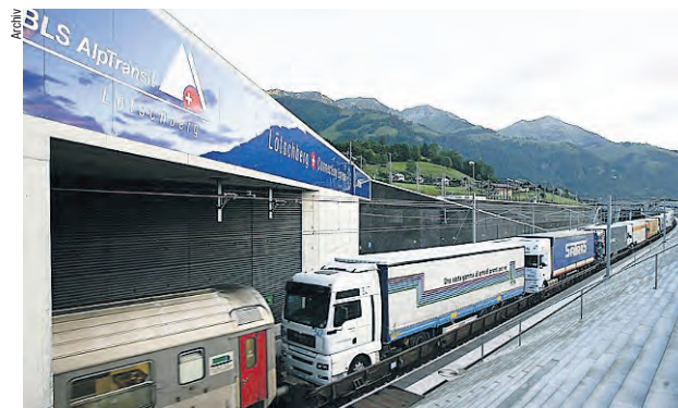
Gut ausgelastet: ein Rola-Zug fährt in den Lötschberg-Basistunnel ein.
