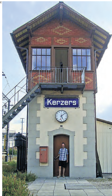
Beat Winterberger vor dem renovierten Wärterstellwerk.
