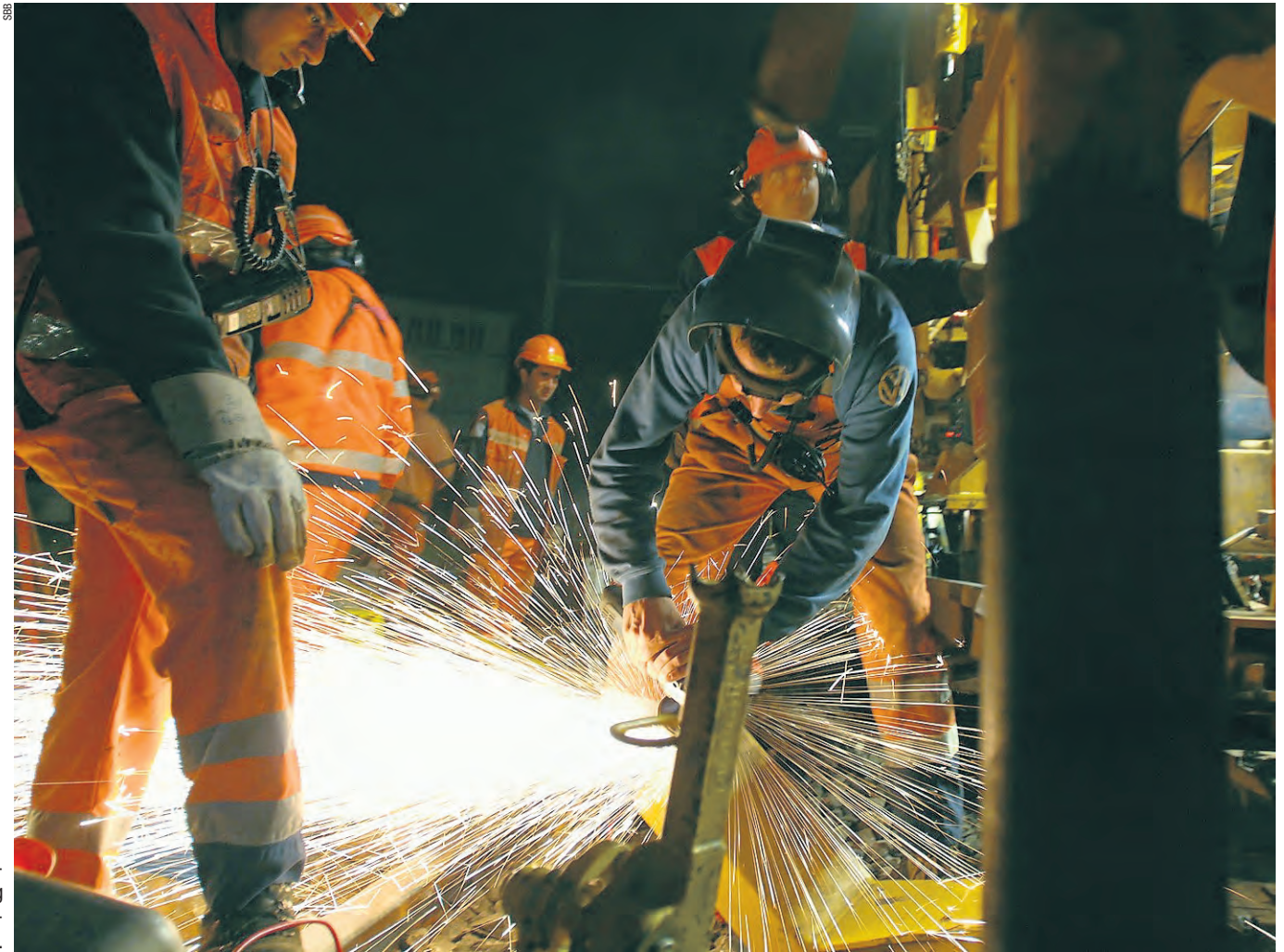
Bei der Division Infrastruktur sind auffällig viele Mitarbeitende tiefer eingereiht worden.
