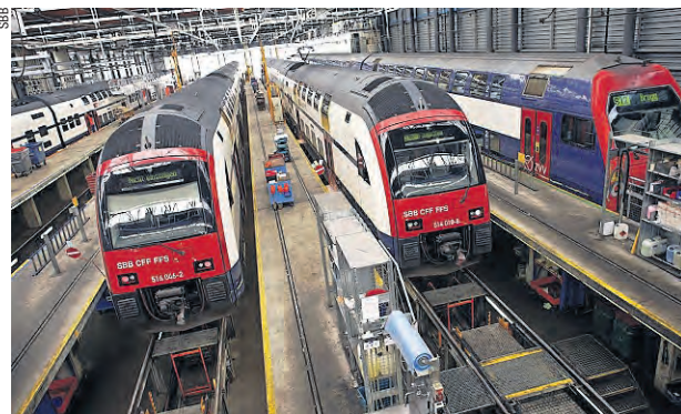
Blick in die Serviceanlage der SBB in Zürich-Herdern.
