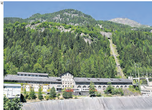
Das Kraftwerk Châtelard, in dem das Museum untergebracht ist. Links im Bild ein Gebäude der riesigen Infrastruktur der Baustelle Nant de Drance.
