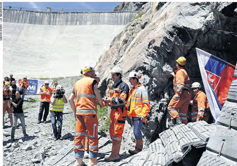
Auf der Baustelle des Pumpspeicherkraftwerkes Nant de Drance am Fuss der Staumauer von Vieux-Emosson haben slowakische Mineure am 4. Juli in einer der zahlreichen Galerien dieser riesigen alpinen Baustelle einen Durchschlag erzielt.
