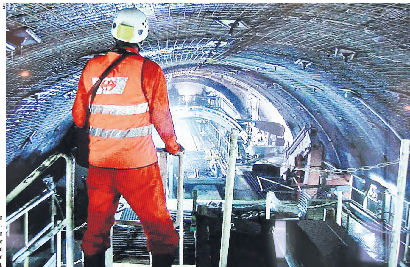
Mit Tunnels und Stollen von 15 km Gesamtlänge ist die Baustelle von Nant de Drance hinter Alptransit Gotthard die zweitgrösste in den Schweizer Alpen.
