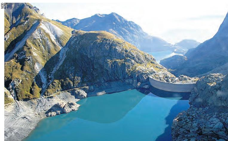
L'acqua sarà pompata dallo sbarramento di Emosson (sullo sfondo) in alto, verso lo sbarramento del Vieux Emosson (qui davanti), la cui diga è stata rialzata di una ventina di metri per aumentare la sua capacità di immagazzinamento, che passerà da 13,5 a 25 milioni di m<sup>3</sup>.
