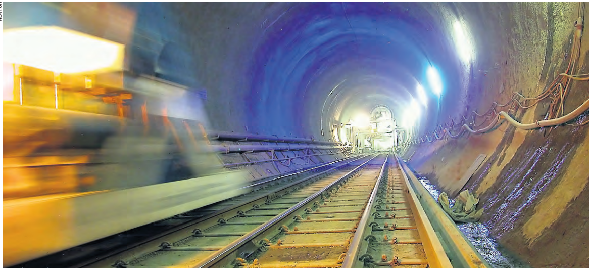
Alptransit-Baustelle Bodio. Wem soll das neue Loch durch die Alpen vor allem dienen – Rosinenpickern oder der ganzen Bevölkerung?
