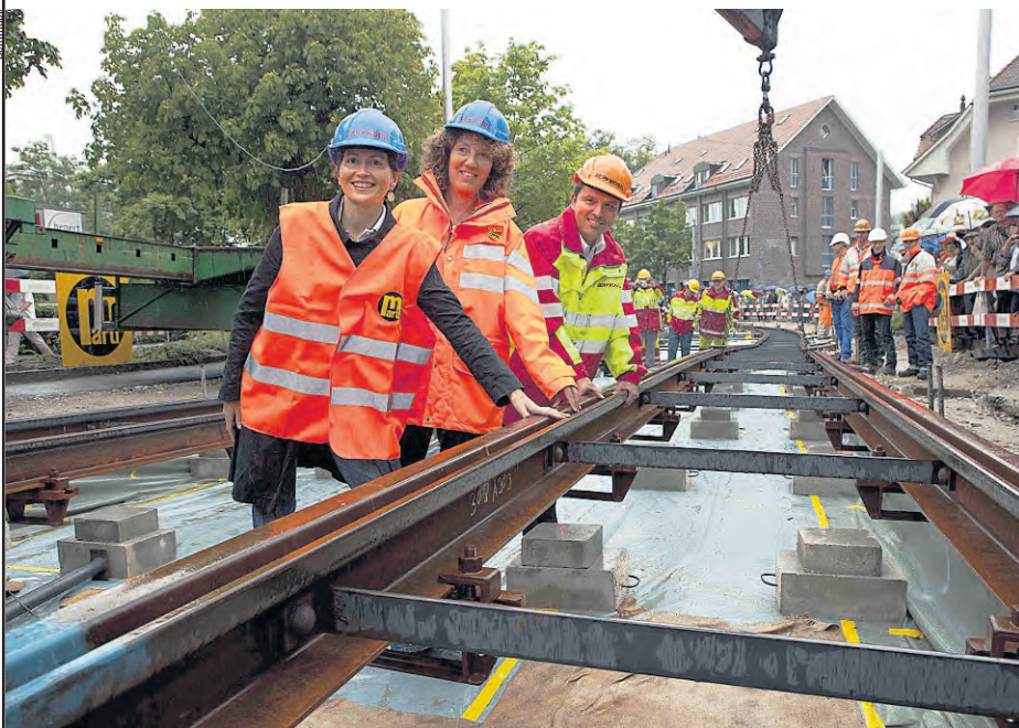
Die letzte Schiene ist verlegt! In Bümpliz freuen sich Gemeinderätin Regula Rytz, Regierungsrätin Barbara Egger und Bermobil-Direktor René Schmied über das bald fertige Tram Bern West.
