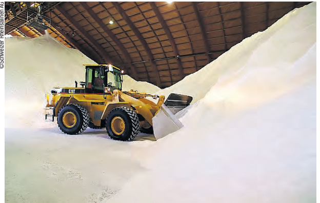
Die Salzlagerhalle der Schweizer Rheinsalinen.
