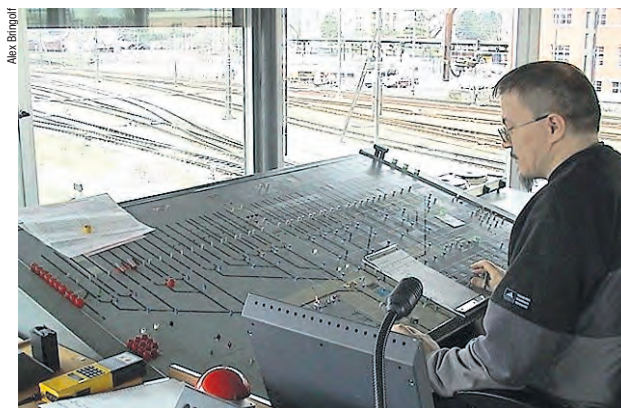
Peter Kern stellt Weichen, nach dem Umbau passiert dies rechnergesteuert.
