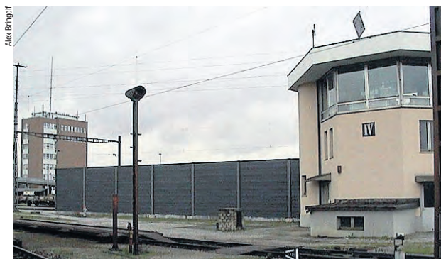
Links das (Zentral-)Stellwerk West und rechts das Stellwerk 4, wo heute die Weichen der Richtungsgleise eingestellt werden – siehe Innenaufnahmen. Es wird voraussichtlich zur Steuerzentrale des Ablaufbetriebs umgebaut.
