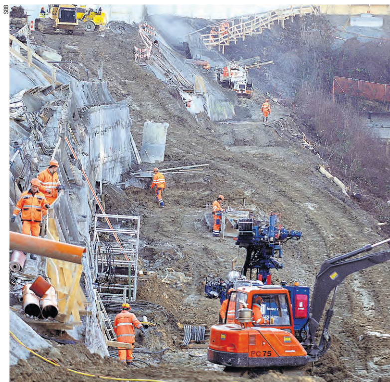
SBB Infrastruktur ist zurzeit eine einzige grosse Baustelle. (Im Bild: Durchmesserlinie Zürich)
