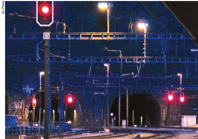
L'aumento dei treni in circolazione richiede più manutenzione, per la quale Infrastruttura FFS necessita, al di là delle riorganizzazioni, maggiori mezzi finanziari. In caso contrario, il ritardo della manutenzione non potrà che aumentare.
