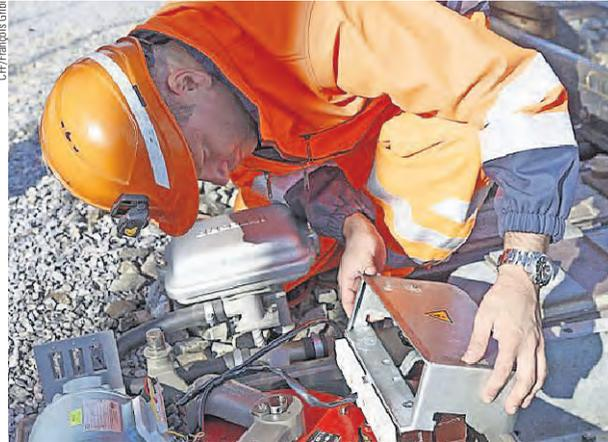
Un monteur d'Infra IH en train de travailler sur un moteur d'aiguille.
