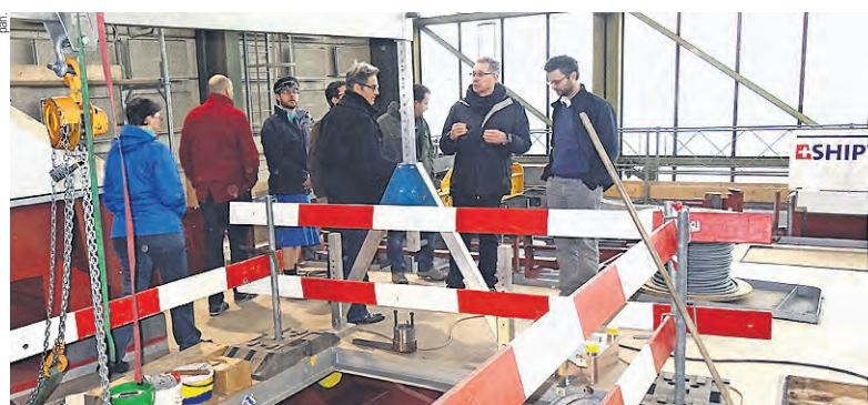
Un momento della visita nel cantiere.
