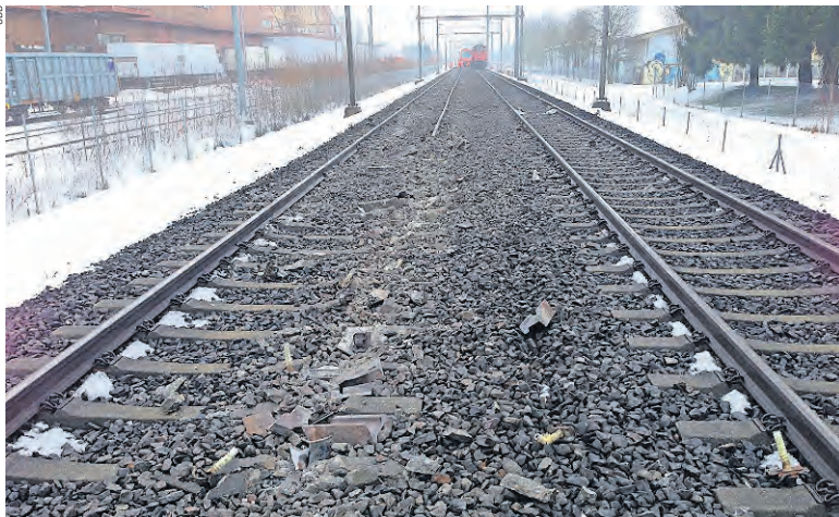
Le 16 février 2013 peu avant 1h30, un train régional a déraillé en raison de la cassure des rails. Les 125 passagers s'en sont sortis indemnes.
