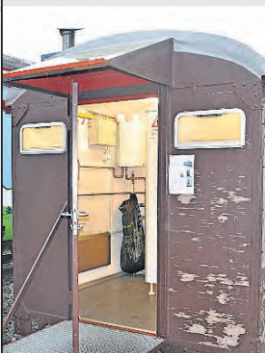
Avant: les toilettes durant plus de 10 ans.
