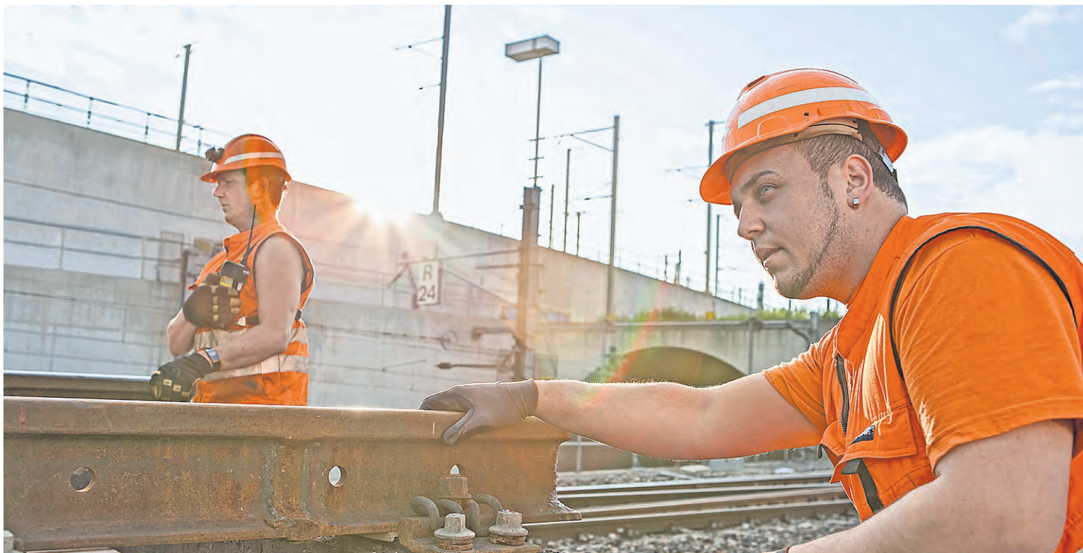
Gli addetti alla costruzione delle linee ferroviarie chiedono da tempo di veder parificate le condizioni di pensionamento anticipato con quelle del settore edile.
